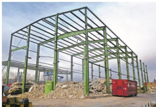
Die einstige Bleibe des Fördervereins auf dem Paule-Gelände wird abgerissen.
